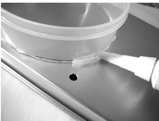
図 3-5-5-7 バスコークを隅に押し付けながら盛る
