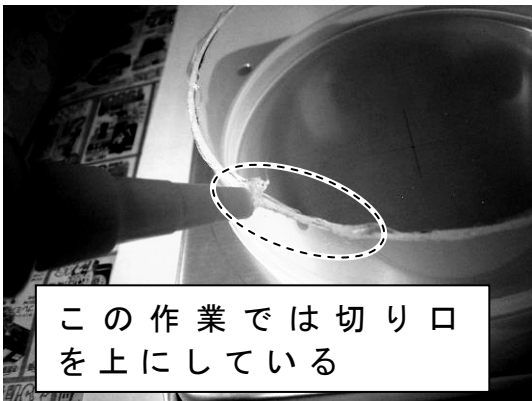
図 3-5-5-5 シリンダの切り口にバスコークを塗る
