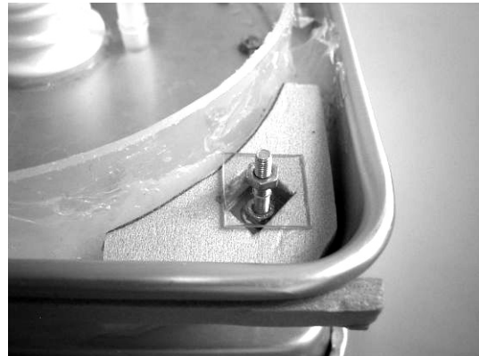
図 3-10-1-9 お湯を捨てる際に脱落し易いパネルは、50mmのボルトと硬質塩化ビニル板の部品を追加して抑えられる
